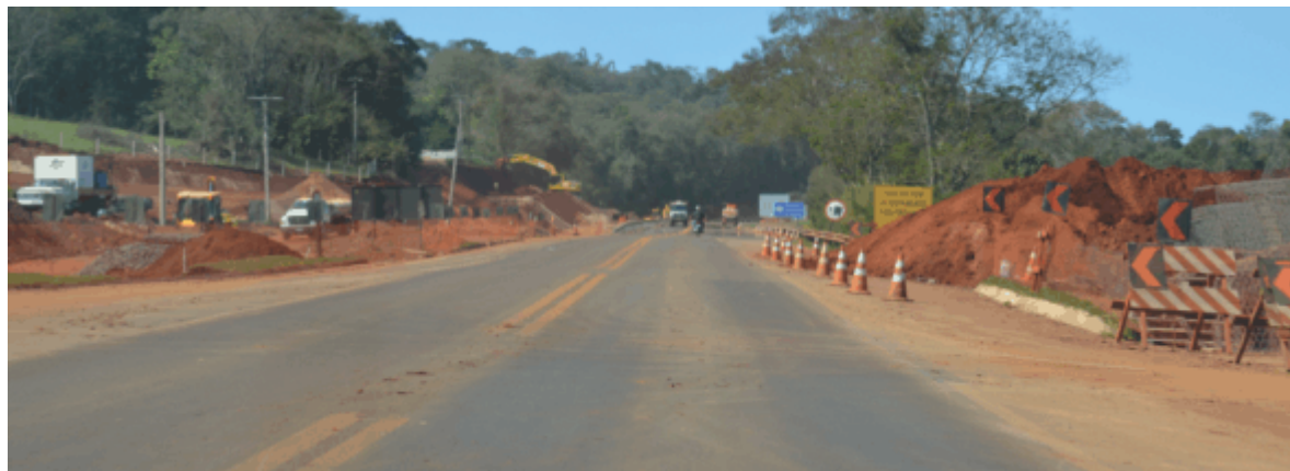
Trecho em obras próximo à Barreira
