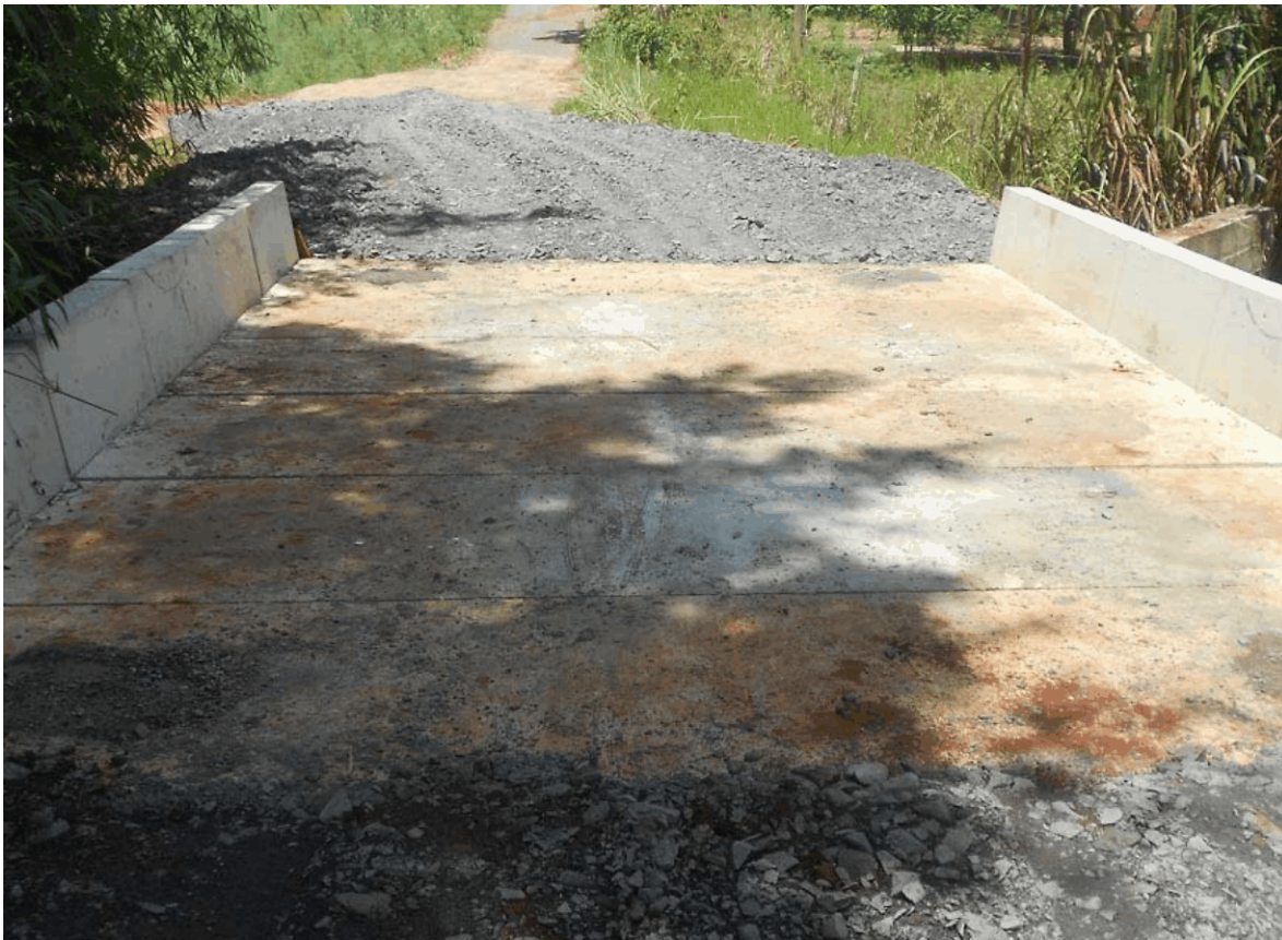
A ponte fica na entrada do bairro e passa por cima do Córrego do Angico . Pág. 3
