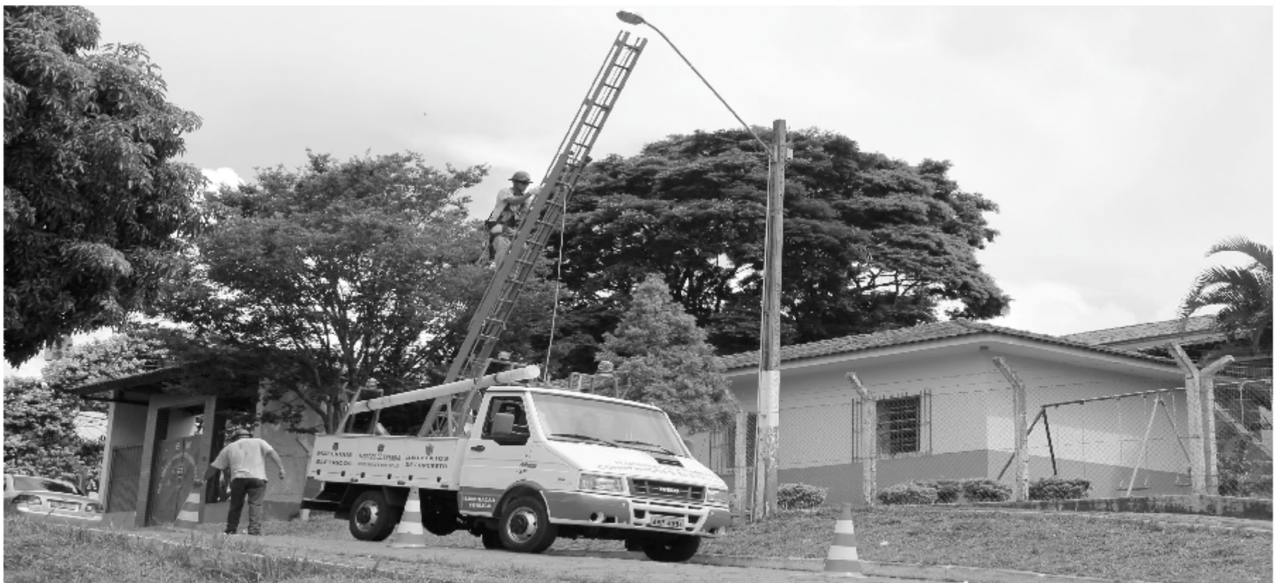
Na tarde da última terça-feira (3) empresa faz reparos na rede de iluminação no bairro Novo Horizonte
