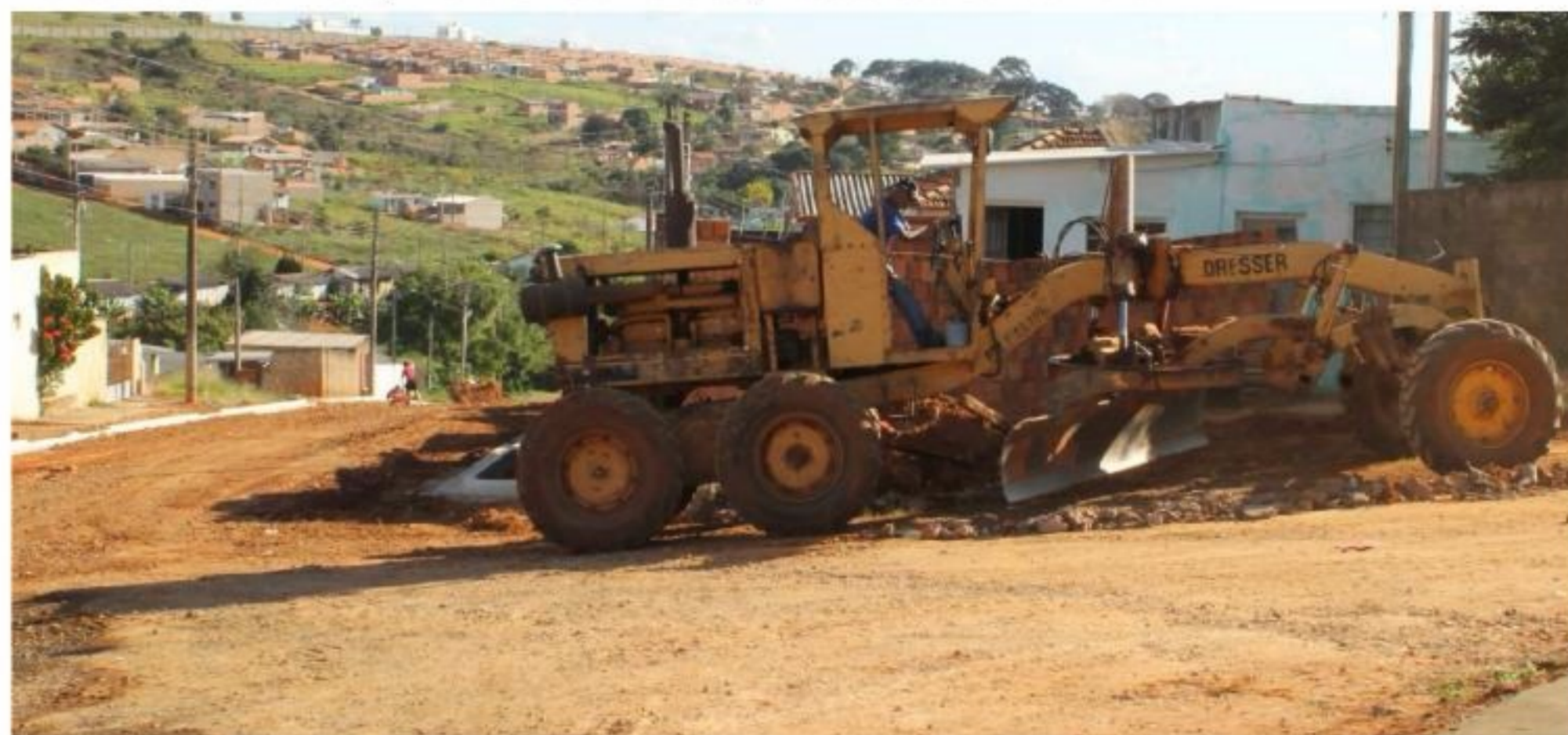
Máquina realiza terraplanagem na rua que receberá o asfalto
