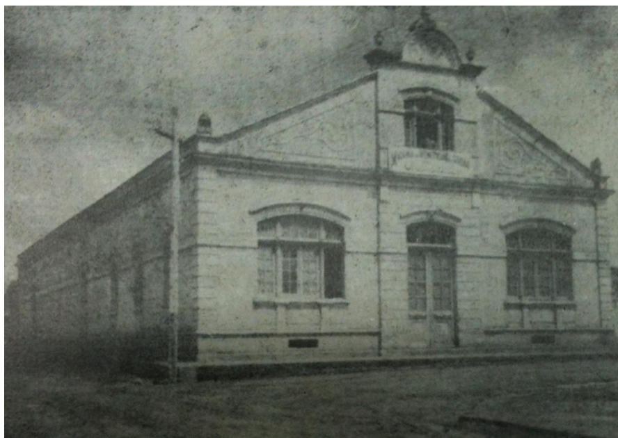
Fachada do edifício do Teatro São Pedro.
