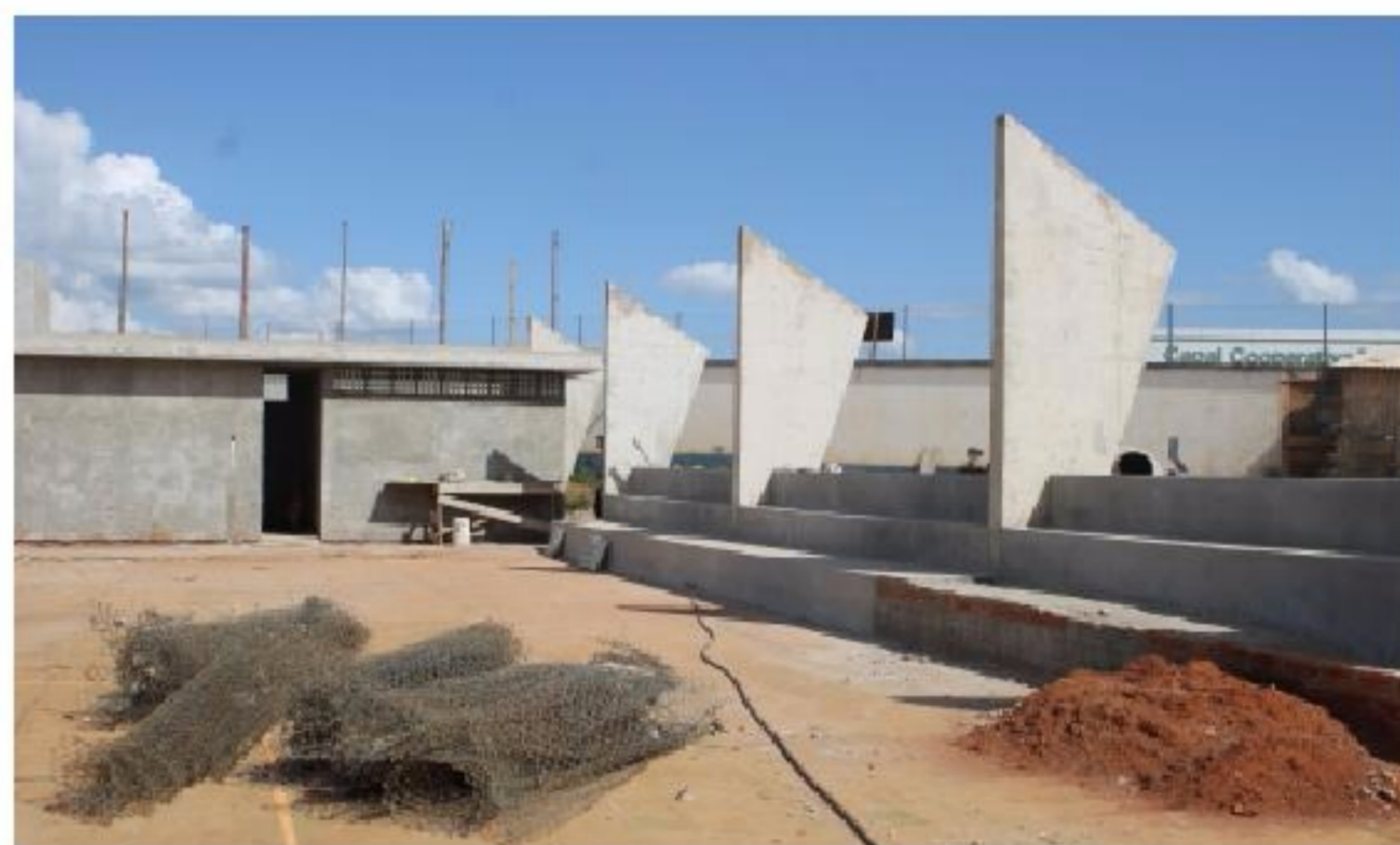
Construção do ginásio poliesportivo da Escola Municipal Professor Juracy Martins - Investimento de R$ 508.872,70
